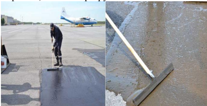
Рисунок 1 – Процесс нанесения пропитки для асфальта резиновым сгоном
