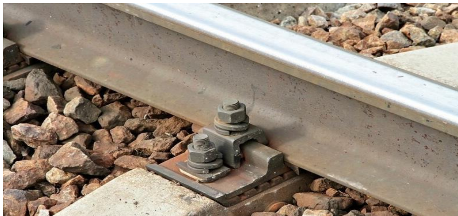
Рисунок 3 – Промежуточное скрепление КБ-65
